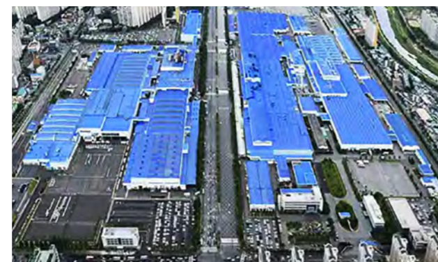
기아자동차 광주공장 전경
