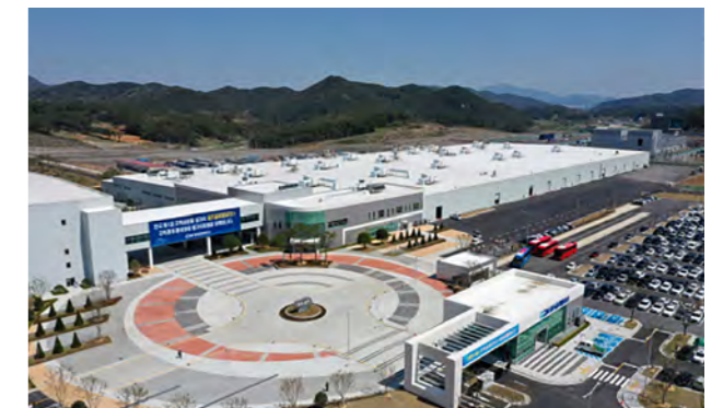
광주글로벌모터스 공장 전경
